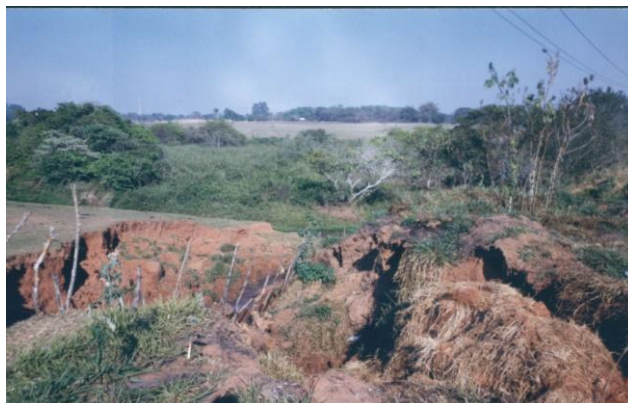
Foto 02: Erosão em propriedades próxima ao rio
