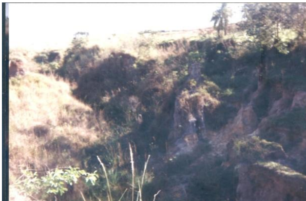
Foto 04: Erosão no entorno do rio
