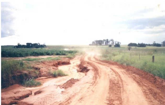
Foto 01: Estrada Rural com erosão
