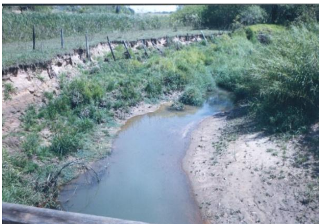
Foto 08: Ribeirão Lajeado – Assoreamento
